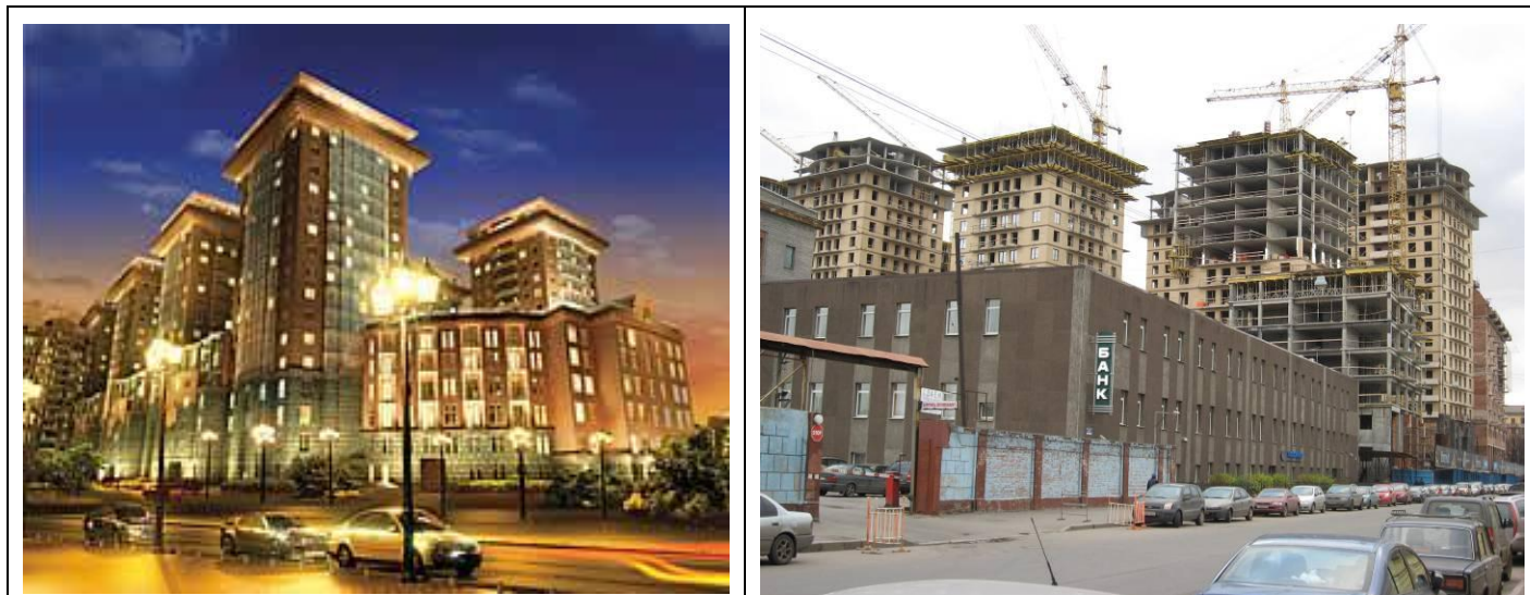
Рис 7,8. Строящийся жилой комплекс «Империял» компании «ЛЭК». Проект. Состояние работ.
